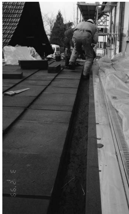
Chromstahlrinne mit Klebeflächen auf Schaumglasunterlage verlegt.
