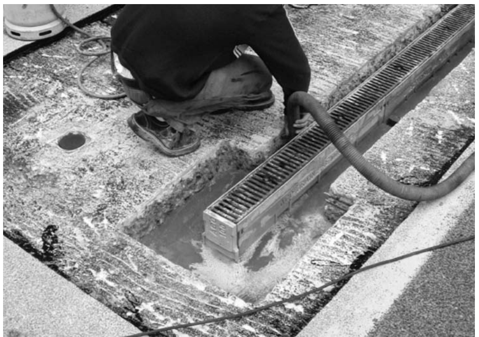
Rinne mit Giessmörtel untergossen und an wasserdichten Ablauf angeschlossen.
