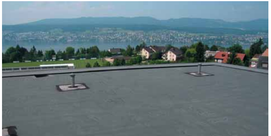
Nacktdach mit Schaumglasdämmung, Bitumenbahn kunststoffbeschichtet.
