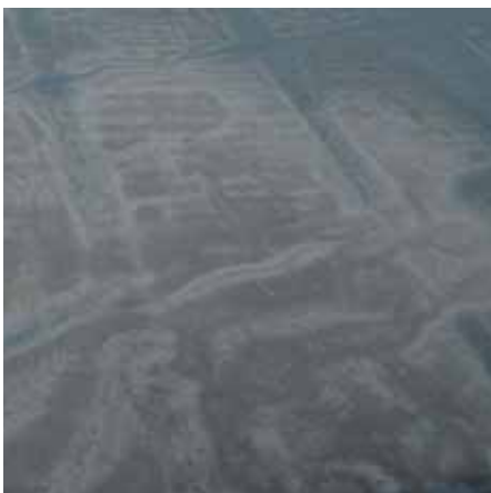
Nacktdach: Oberfläche der Dachhaut, Plattenstösse der Schaumglaswärmedämmung sichtbar.
