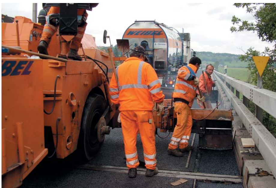
Bild 3: Seitenfertiger, Bohle mit Rigolenform.
