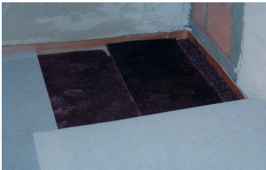
Bild 5 zu Beispiel 3: Bodenaufbau vor dem Einbringen des Gussasphalts: Splitt, Trittschall, Perlite-Platten oder alter Unterlagsboden, Trennlage. Am Rande wird ein Stellstreifen aus Wellkarton erstellt.
