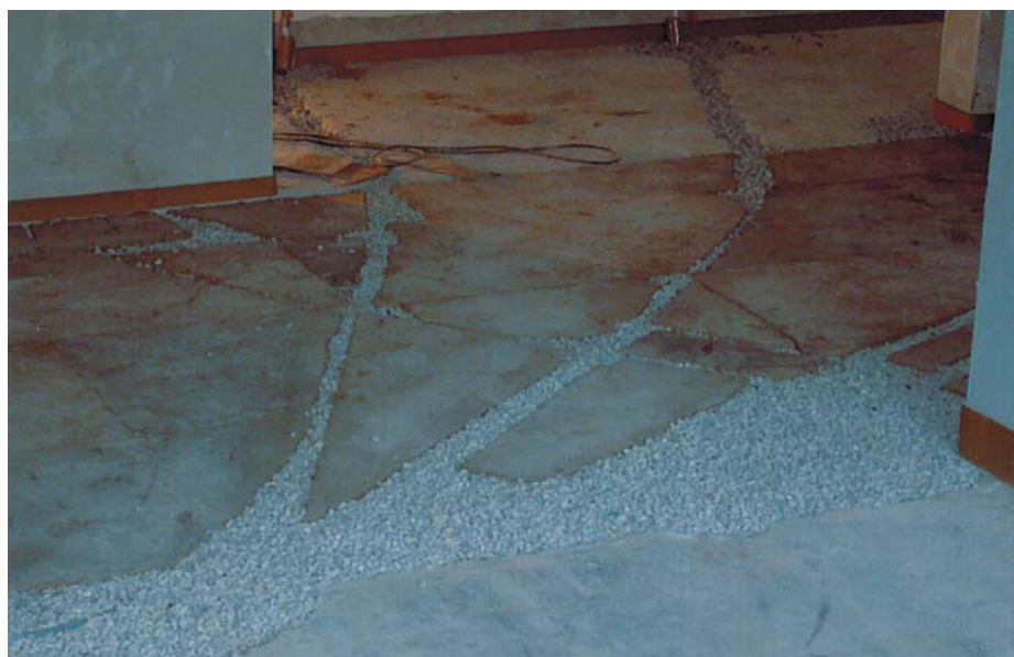
Bild 4 zu Beispiel 3: Die Hohlräume neben den verlegten neuen Leitungen werden mit trockenem Splitt verfüllt.
