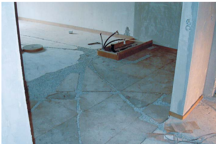
Bild 3 zu Beispiel 3: Detailaufnahme der Perlite-Platten.
