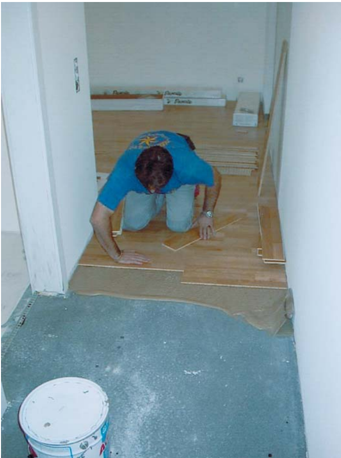
Bild 8 zu Beispiel 3: Verlegen des geklebten Parketts.
