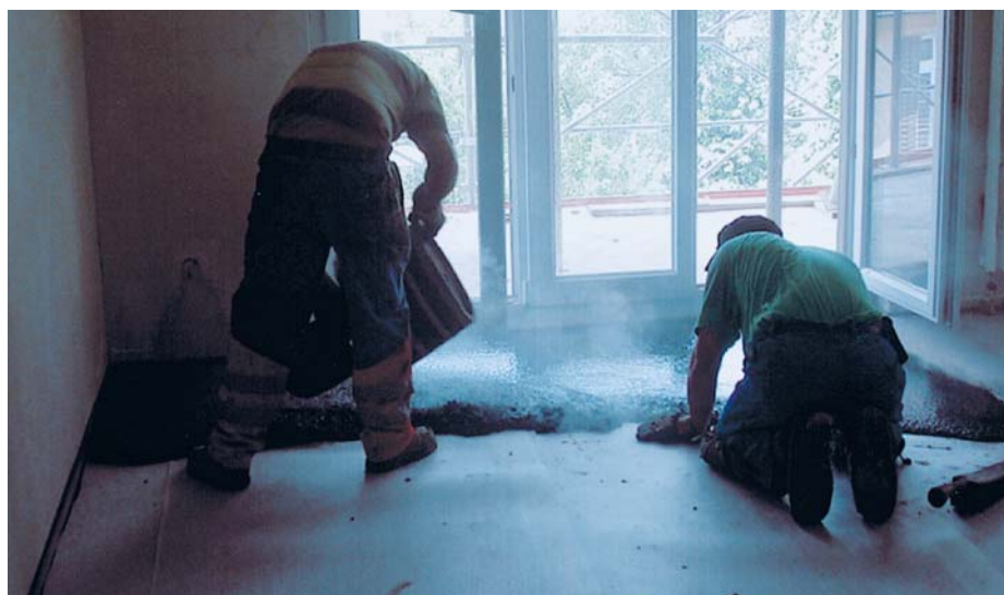
Bild 6 zu Beispiel 3: Einbau des Gussasphalts.
