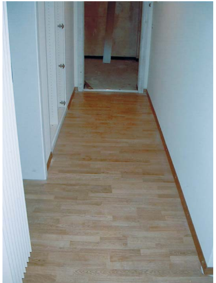
Bild 9 zu Beispiel 3: Fertig erstellter Nutzbelag (Parkett).
