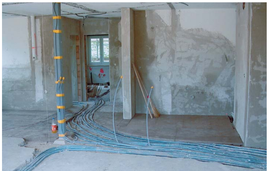
Bild 2 zu Beispiel 3: Mit Perlite-Platten (rechts hinten) werden die grösseren Niveau-Unterschiede ausgeglichen.
