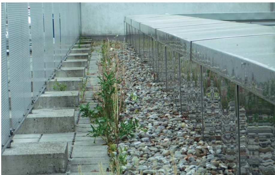
Regelmässige Unterhaltsarbeiten verhindern einen unerwünschten Pflanzenwuchs auf dem Flachdach.
