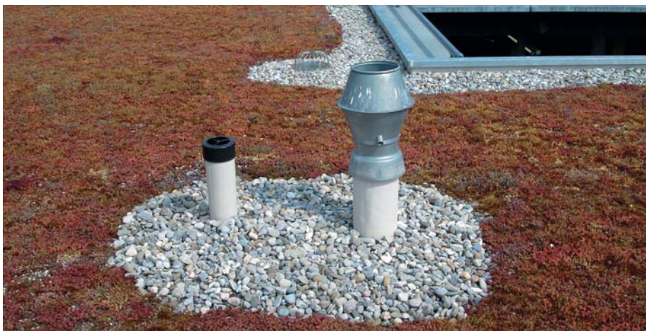
Beispiel eines gut unterhaltenen Flachdaches – der Kiesstreifen ist frei von Fremdbewuchs.
