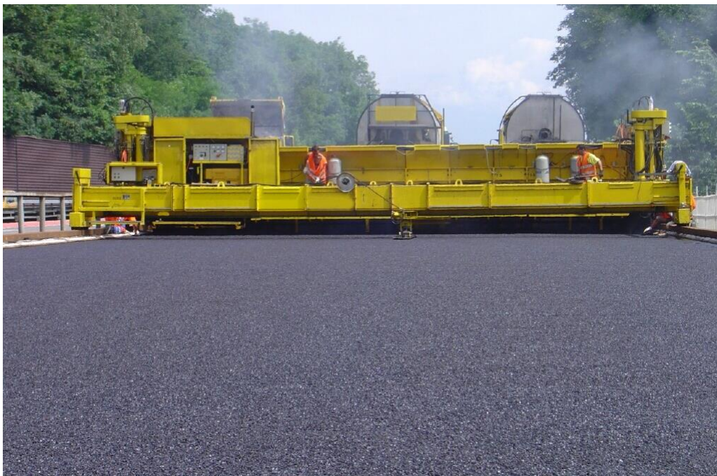
Gussasphalt Grossdeckenfertiger mit Oberflächenbearbeitungsgerät
