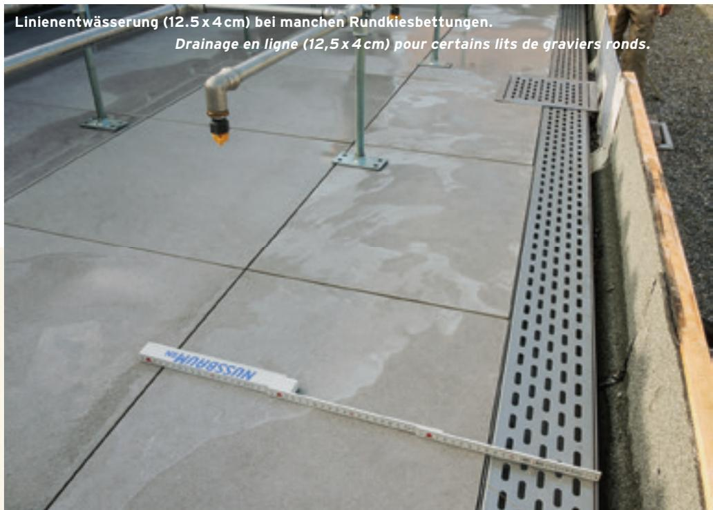
**Verwendete grossformatige Keramikplatten (120 x 60 cm), Fugenbreite 3 mm.**
