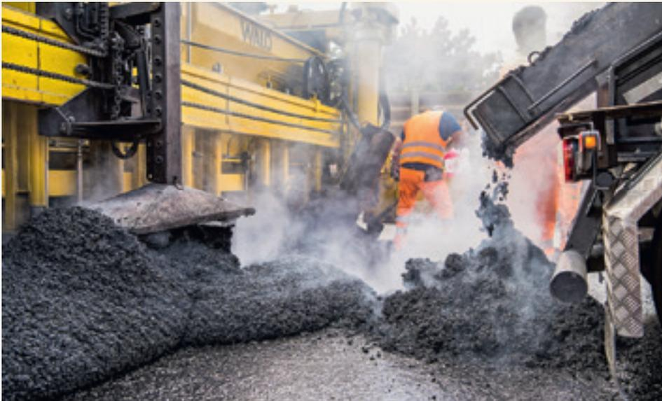
Der Gussasphalt wird in einem Temperaturbereich von 200 bis 230 Grad Celsius eingebaut.
