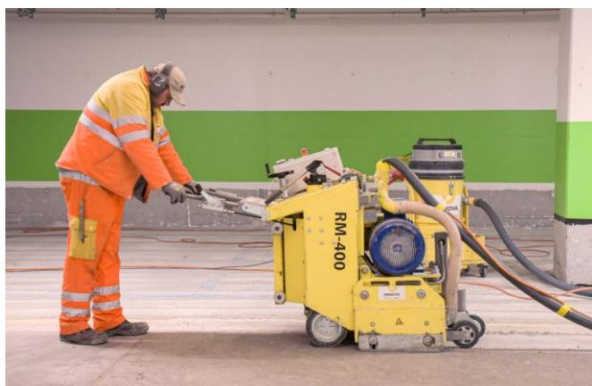
Fräsarbeiten in einem Innenraum.
